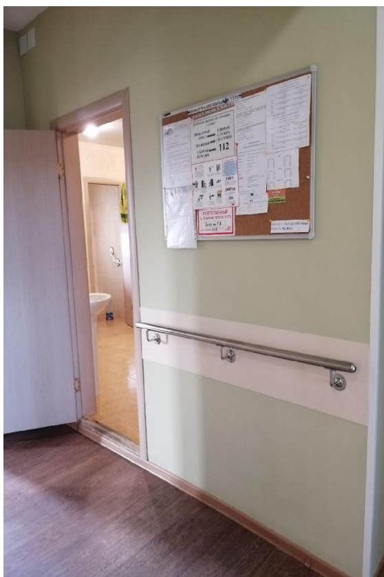
Вход в санузел 1-го этажа
