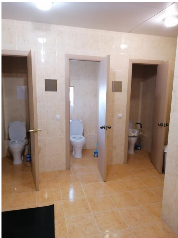
Санузел (туалетные кабины) 1-ый этаж
