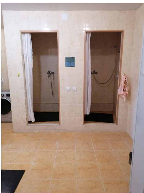
Санузел (душевые кабины) 1-ый этаж
